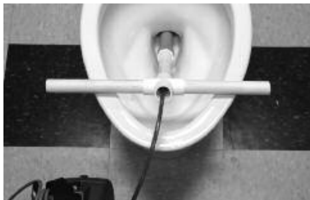
Рис. 24. Использование направляющей трубы из поливинилхлорида
