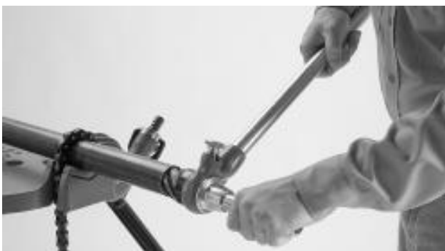
Рис. 2 – Зенкование края трубы.
