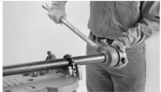
Рис. 3 –Установка инструмента на трубе.
