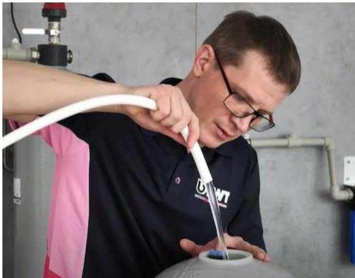
Заполнить корпус установки водой приблизительно на 1/4 объема. Вода будет служить буфером при засыпке фильтрующего материала.
