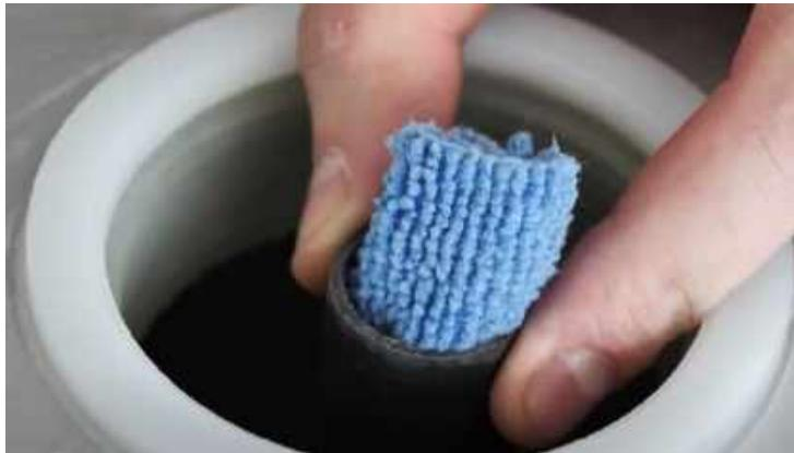
Закрыть верхнее отверстие водоподъемной трубы плотной пробкой из любого материала так, чтобы ни при каких условиях эта пробка не могла провалиться внутрь трубы. В противном случае это приведет к невозможности использования этого элемента установки.
