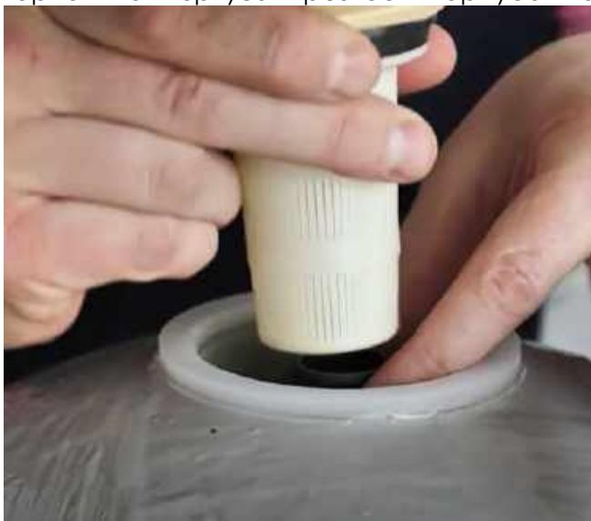
Плотно закрутить управляющий клапан в корпус установки. Не использовать для этого рычаги, захваты или другой инструмент!
