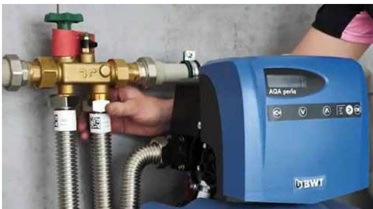
**! ВНИМАНИЕ:** Перекос управляющего клапана при закручивании может привести к повреждению резьбы горловины корпуса установки!
