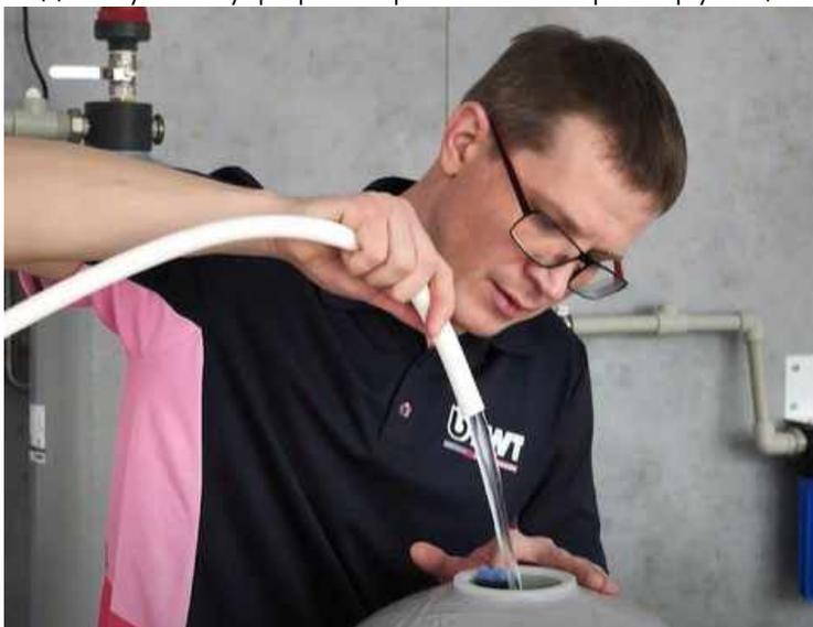
Установить в горловину корпуса воронку. Коллектор может при этом немного отклоняться от вертикали, но нижнее дренажное устройство не должно выходить из своего посадочного места на дне корпуса.
