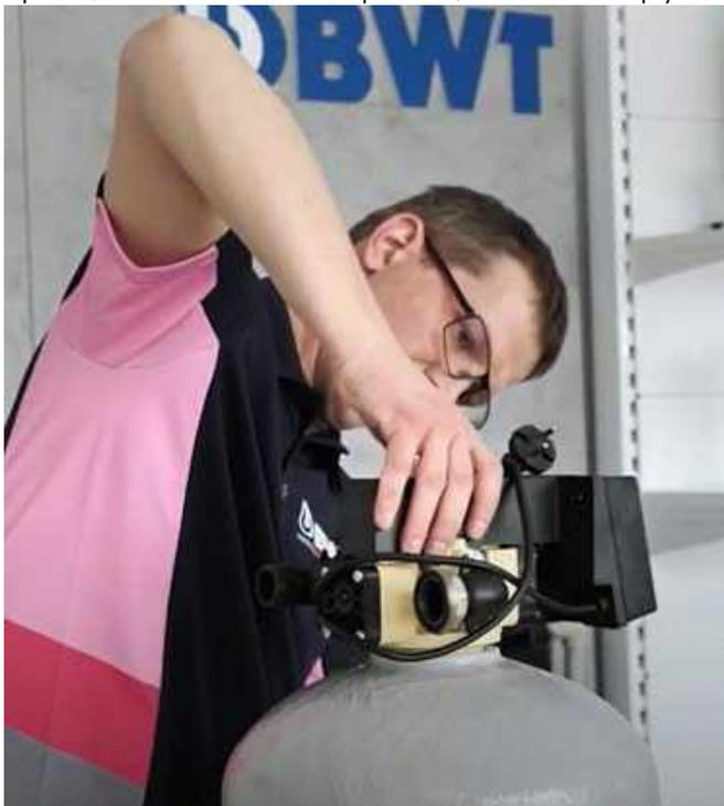
**! ВНИМАНИЕ:** перекус блока управления при закручивании может привести к повреждению резьбовой части горловины!
