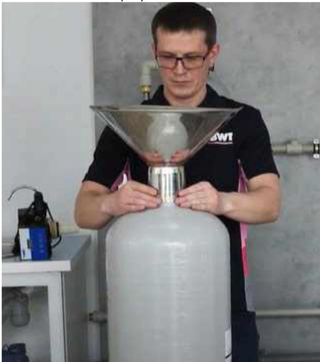
Засыпать в корпус через воронку расчетное количество фильтрующего материала.
